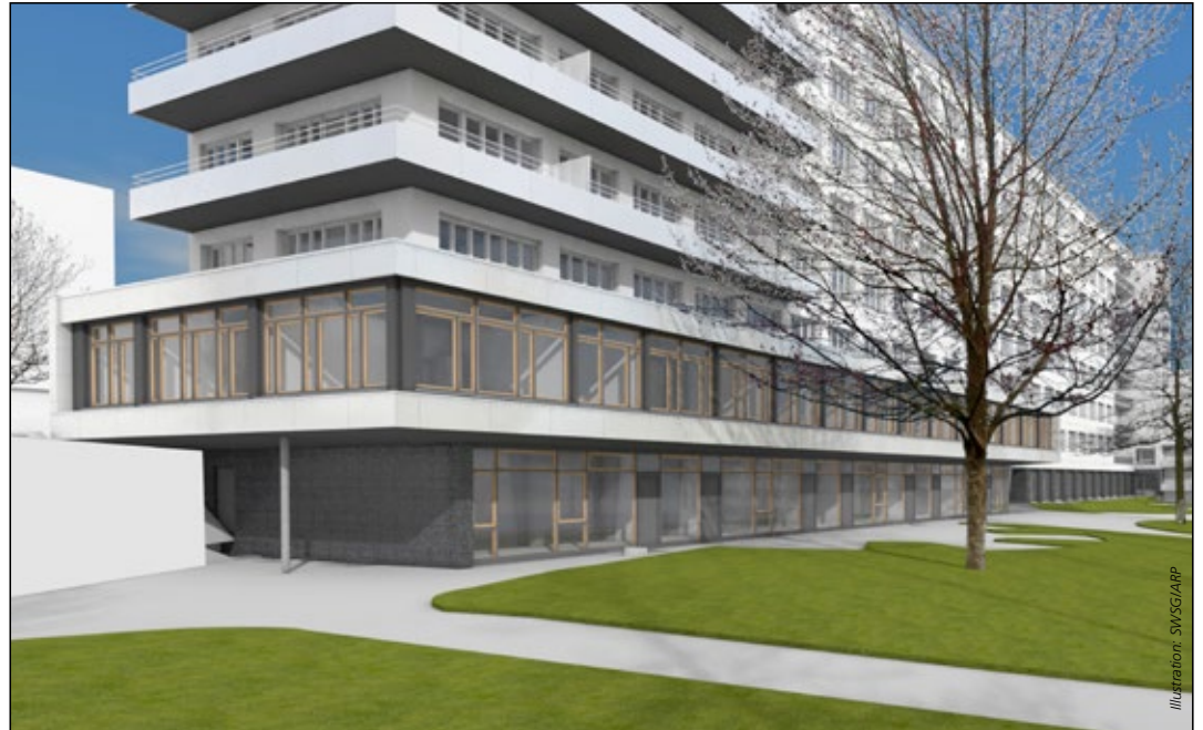
Das Bettenhaus des Klinikums an der Tunzhofer Straße, ein Projekt der SWVG
