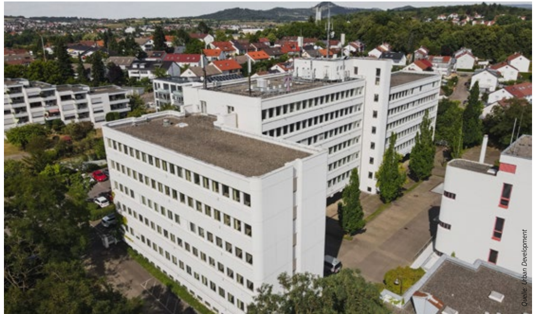
Das alte Telekomgebäude wird komplett entkernt
