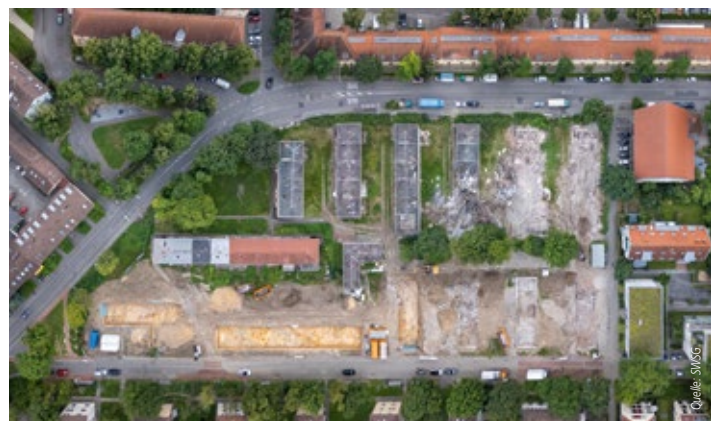
Der Altbestand wurde abgerissen
