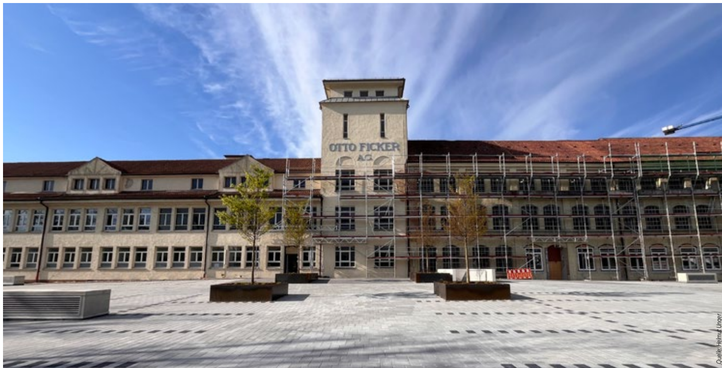
Der Westflügel des Hauptgebäudes wird aufwendig saniert, der Ostflügel bietet noch Potenziale
