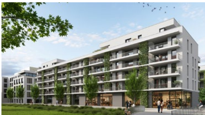
SWSG baut im Stuttgarter Neckarpark mit Rommel
