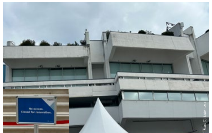
Abgedunkelt und leer, früher war hier die Stuttgart-Terrasse
