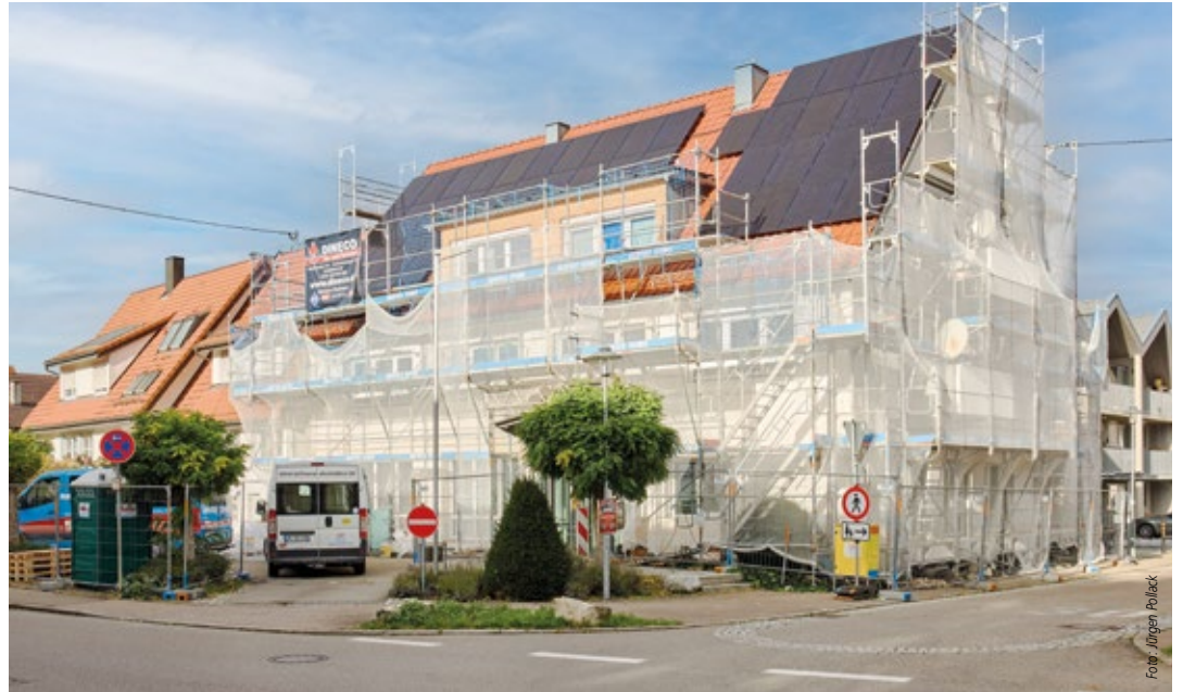
Mit der klimaneutralen Sanierung der Filialen der KSK Esslingen-Nürtingen sammelte Lava Erfahrung
