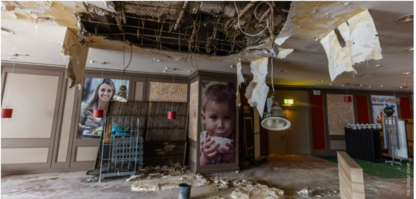
Die Galeria Kaufhof an der Eberhardstraße will die Stadt nach dem IBA'27-Ausstellungsjahr nutzen, doch vorher steht eine Generalsanierung an
