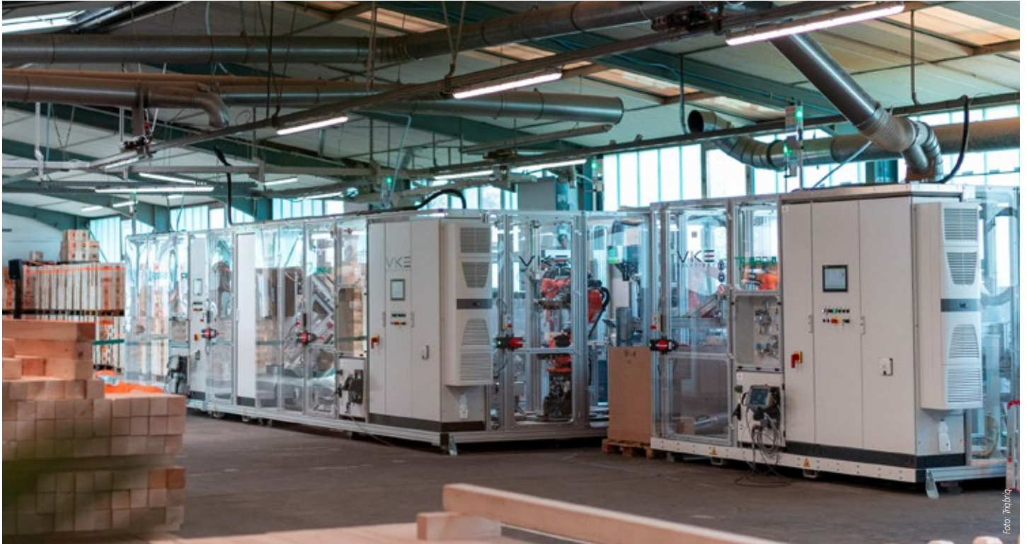
1,8 bis 2 Millionen Euro kostet die Anlage, laut Hersteller ist sie wartungsarm
