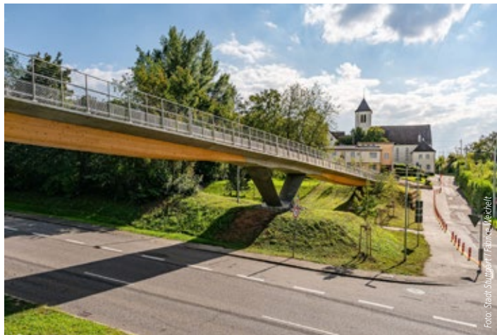
Wolff & Müller baut die erste Holzhybridbrücke Stuttgarts
