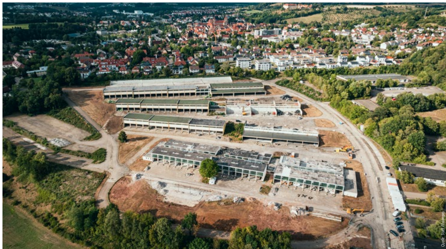
Die ehemaligen Militärgebäude müssen weichen – 105 000 Kubikmeter werden abgerissen
