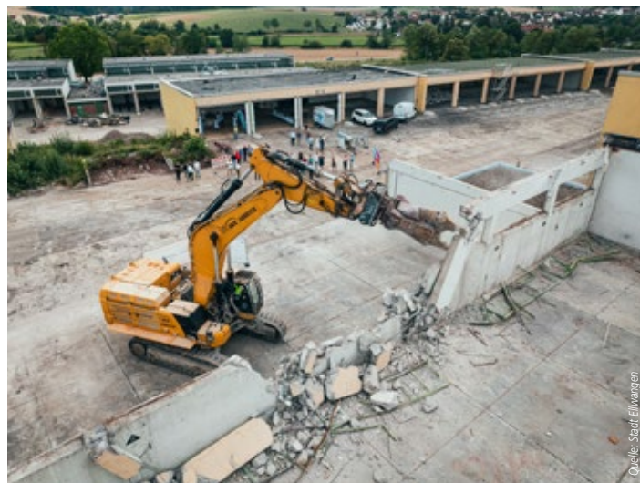
Der Abbruchbeton soll recycelt werden
